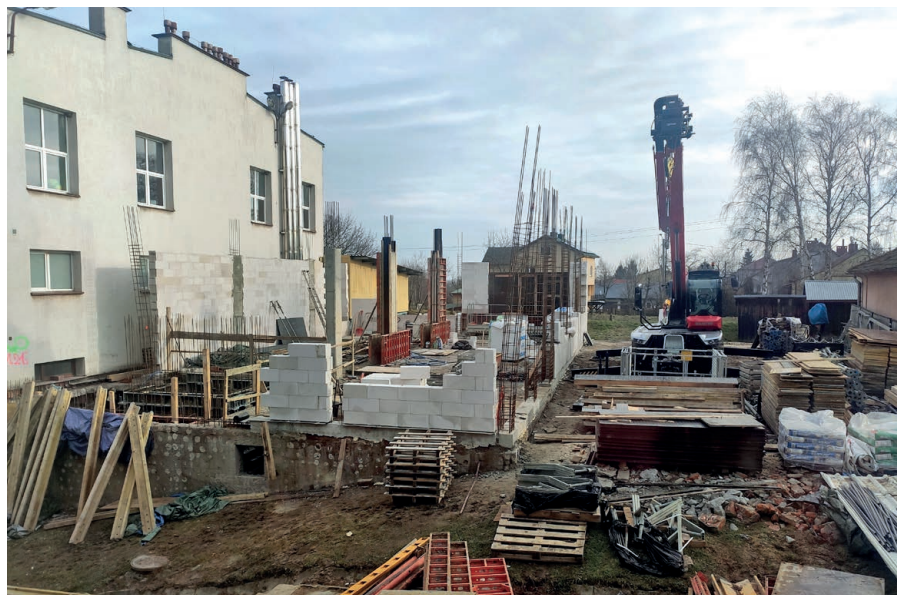
Budowa BCU 2024 r.
