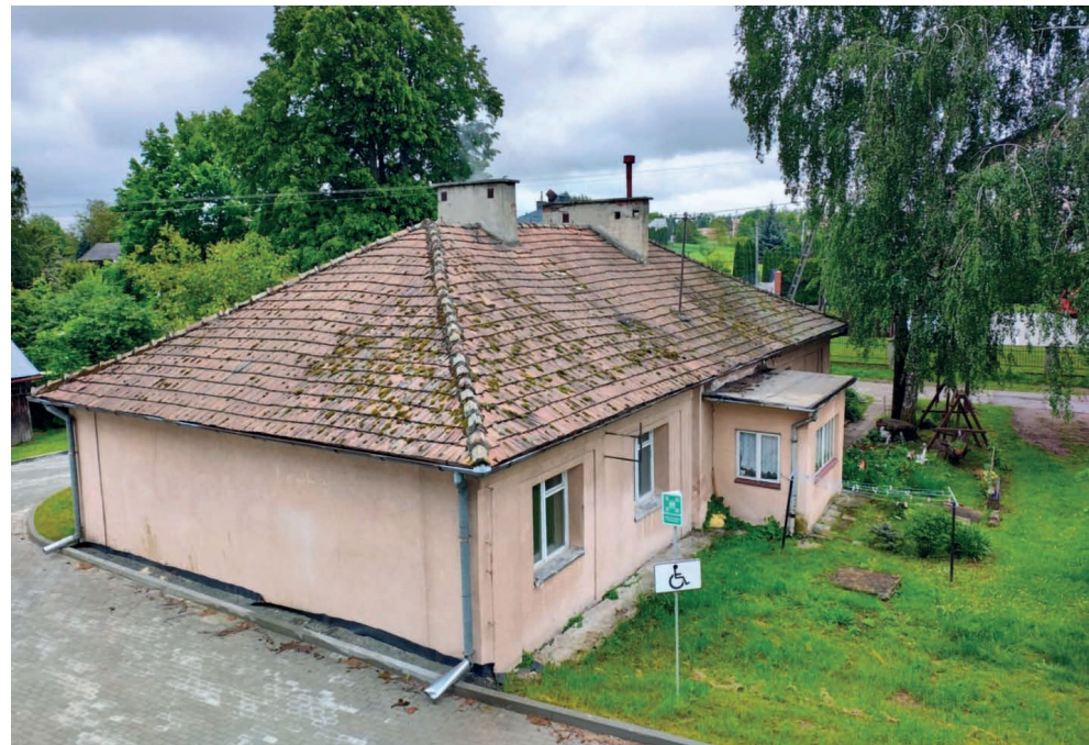
Budynek dawnych czworaków
