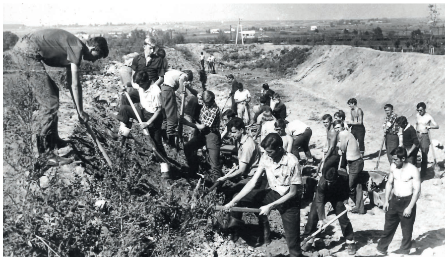
Budowa szkolnej strzelnicy 1968 r.
