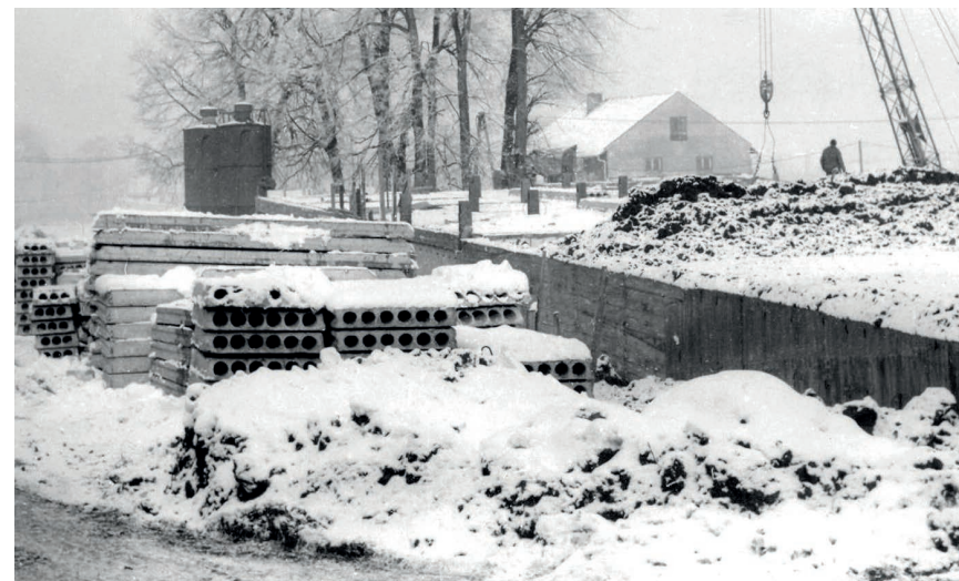
Budowa nowej szkoły
