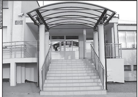
Internat - wejście główne po remoncie.
