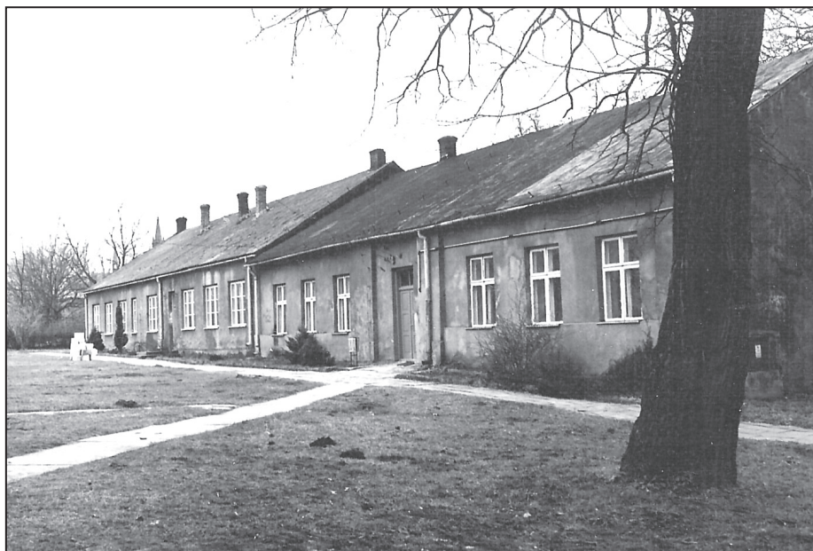
Budynek szkolny do 1997 r.
