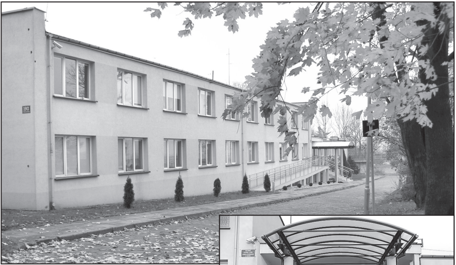
Internat - elewacja wschodnia.
