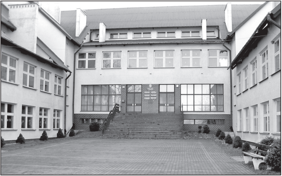
Elewacja północna nowego budynku szkoły.
