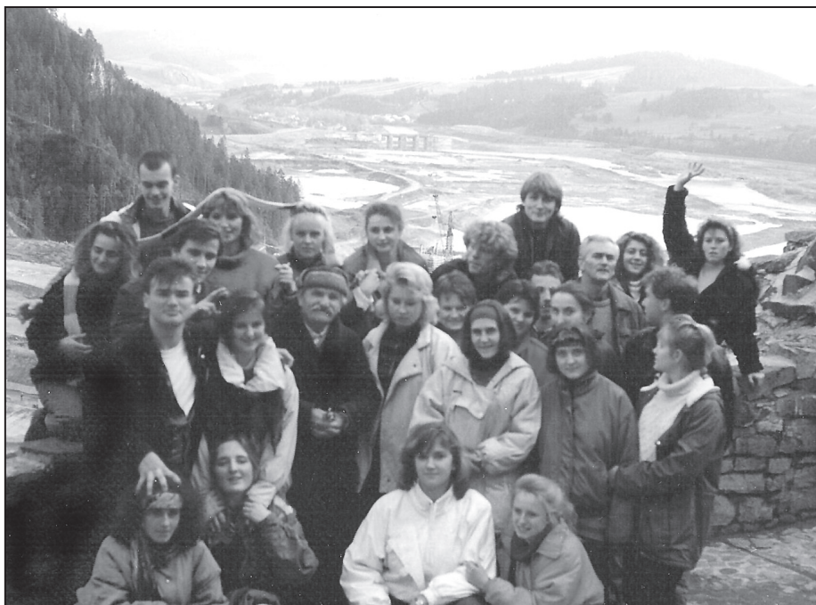
II rok PZS Ochrona Środowiska. Wycieczka zawodowa. Zapora wodna w Czorsztynie w budowie. 1993 r.
