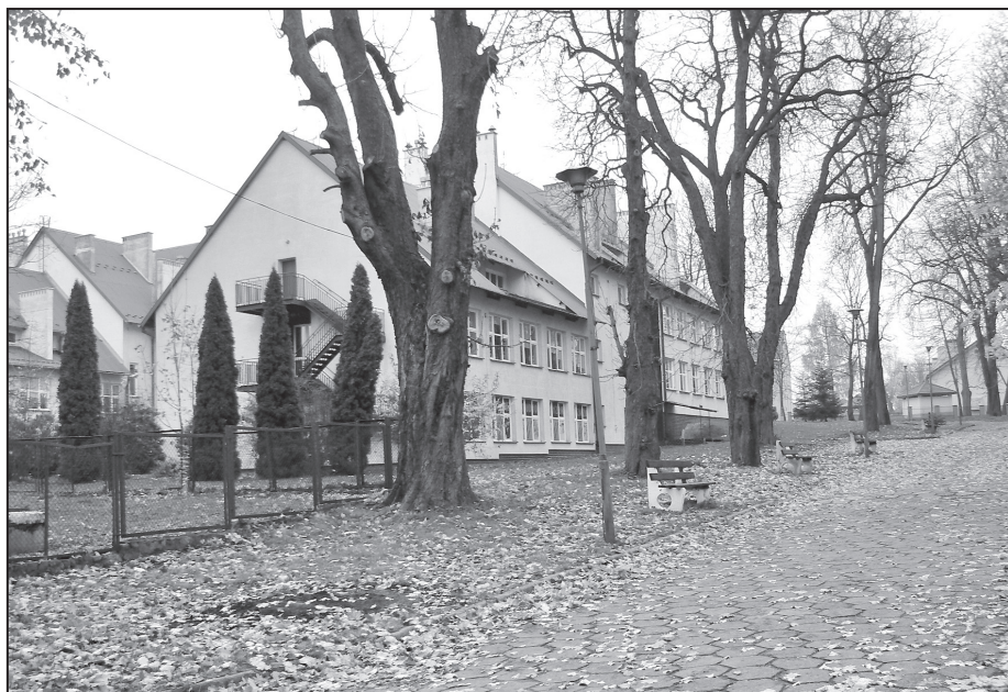
Budynek szkoły - elewacja zachodnia.
