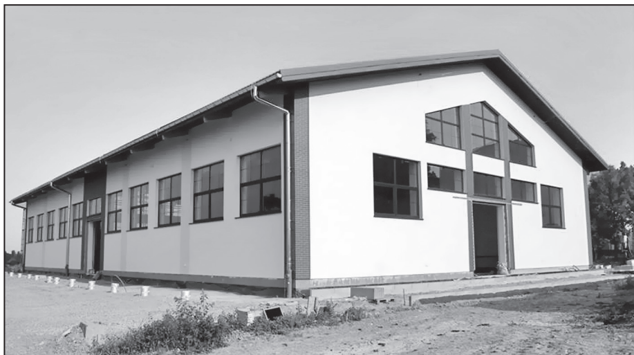
Kryta ujeżdżalnia koni w trakcie budowy, 2015 r.
