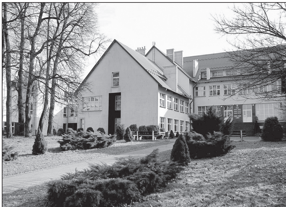
Budynek szkoły - elewacja północna.
