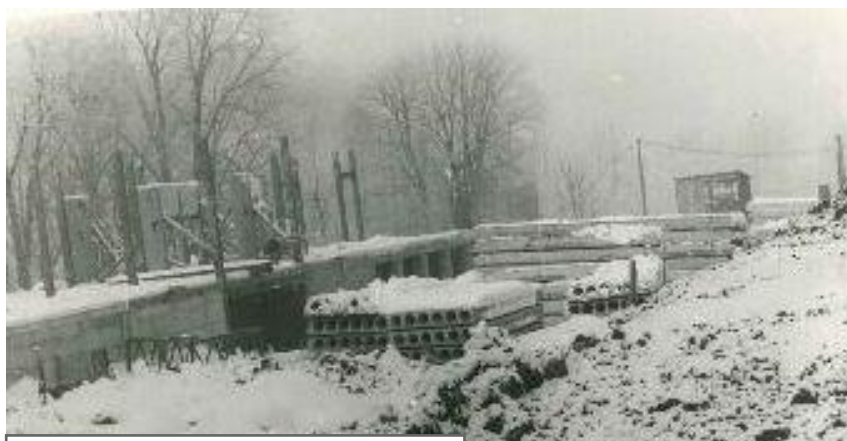
Budowa nowego budynku szkoły ruszyła w roku 1985
